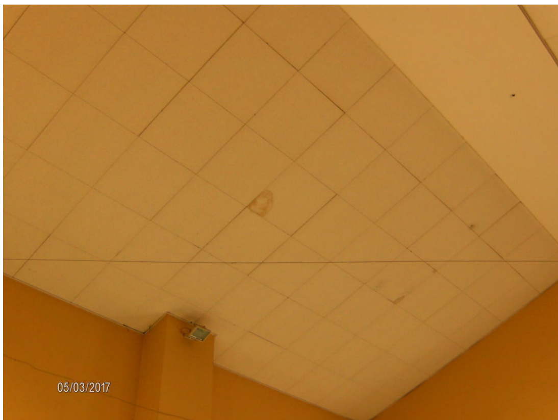
Sostre sala central
