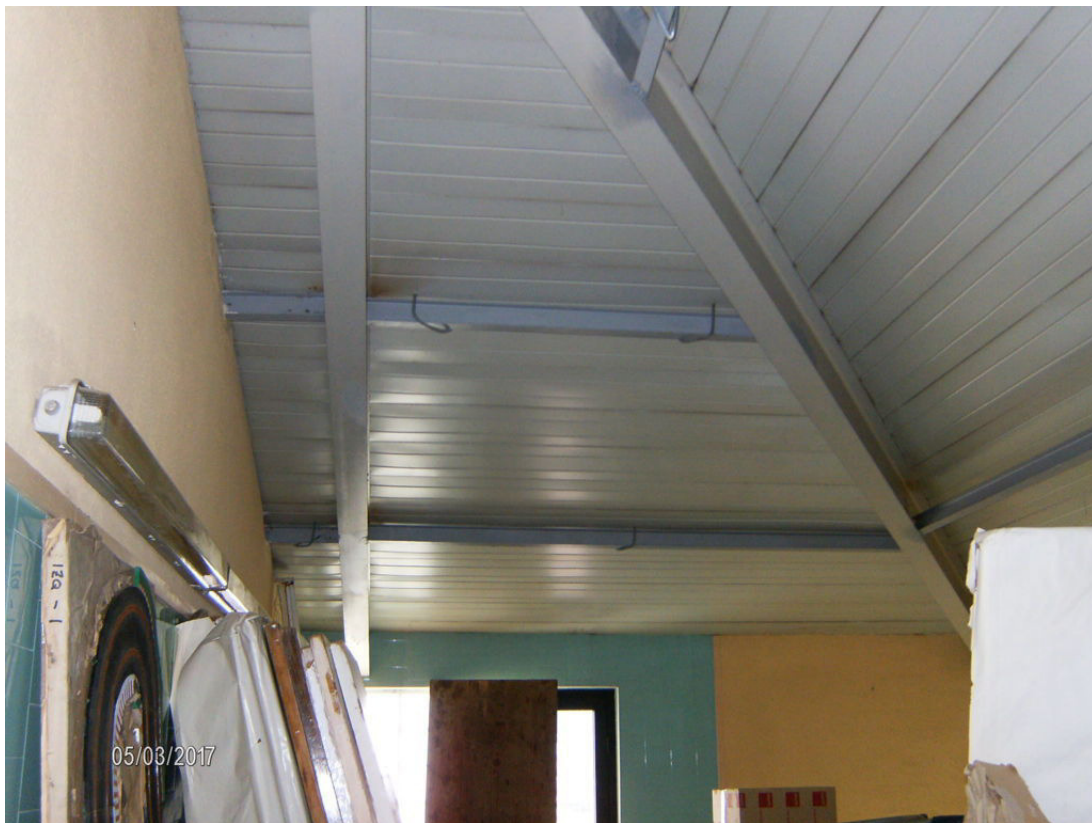
Estructura metàl·lica coberta
