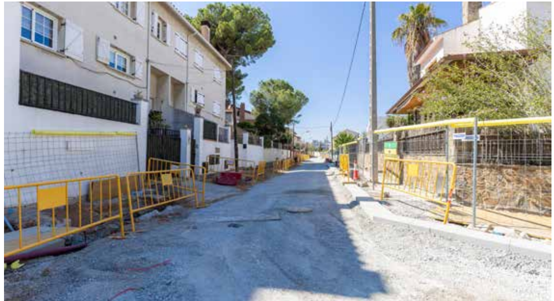
Las obras corresponden a la primera fase de la reurbanización de la calle Sol
